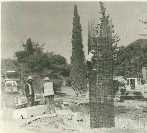
Αριστερά: Ο συνδελός σκαφαλωμένος οαν χυμιάτης σε ύψος 5 μέτρων. Επάνω, απαράδεκτες συνθήκες εργασίας στο Ολυμπιακό Χωρό
