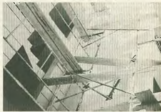
Σκαλωσιάς από εργασίες επιτηρημένου υπεργολάβου στην Β' Κ/Ξ στο Ολυμπιακό Χαριό
